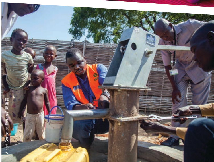
樂施會人員在全國多處修復水管，及檢測食水衛生，以確保水質安全。
